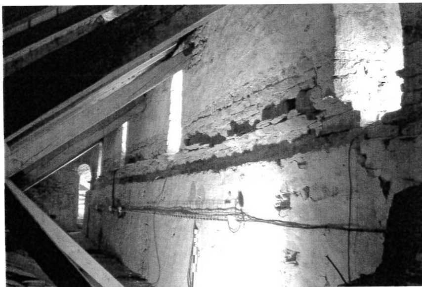
Fig. 2 – Saint-Lupicin, nef, comble du bas-côté nord, solin de la toiture primitive (cl. M. Čaušević-Bully)
