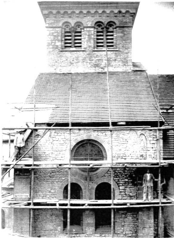
Fig. 16 – Saint-Lupicin, la façade du bras nord du transept pendant les travaux de restauration, vers 1932 (coll. part.)
