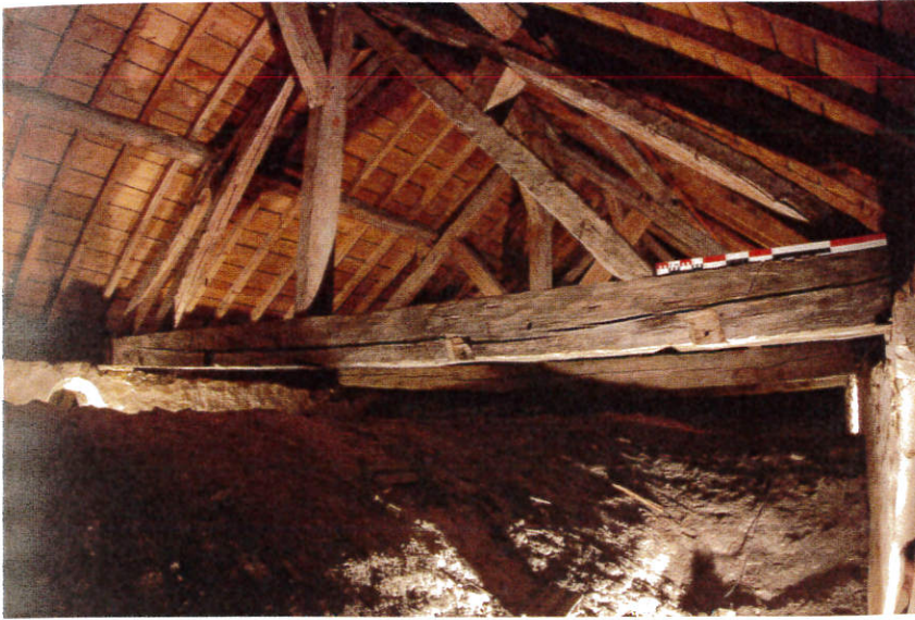
Fig. 4 – Saint-Lupicin, charpente du vaisseau central de la nef, entrant du XIV e siècle en remploi (cl. L. Fiocchi)
