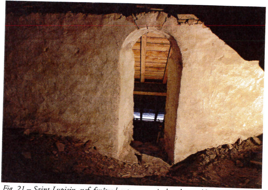
Fig. 21 – Saint-Lupicin, nef, fenêtre haute conservée dans les combles du bas-côté nord (état avant travaux de restauration) (cl. S. Bully)
