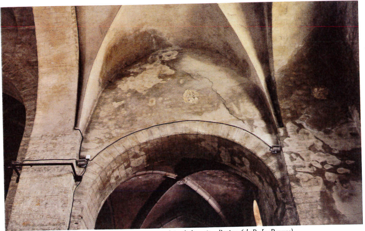
Fig. 18 – Saint-Lupicin, bras nord du transept, retombées de la voûte d'arêtes (cl. R. Le Pennec)
