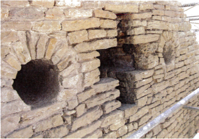
Fig. 10 – Saint-Lupicin, façade occidentale, détail des oculi et de la baie en forme de croix grecque du pignon (cl. S. Bully)
